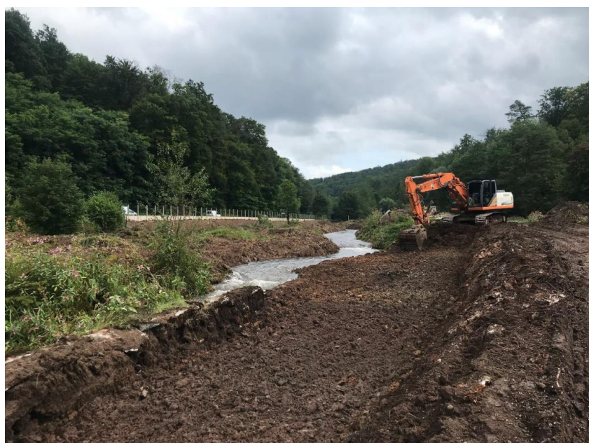
Figure 1 : Réalisation d'une rampe en enrochement au droit du vannage et terrassement sur le site de l'ancienne pisciculture à Liebfrauenthal
